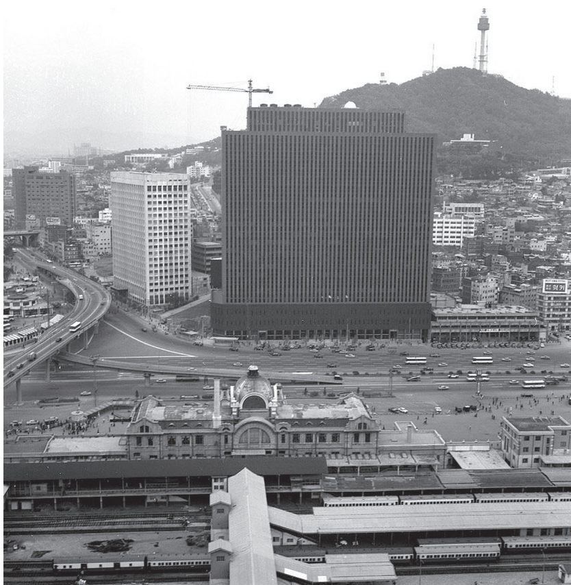
준공을 앞둔 대우빌딩(1976년) (출처-국가기록원)
