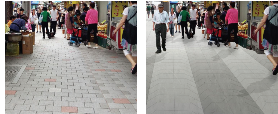
퇴계로 보행환경 개선공사로 정비한 인도(변경 전과 변경 후) (출처:중구청)
