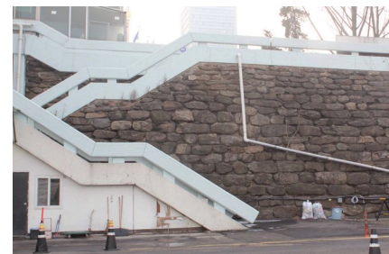
자유센터 정문 오른쪽의 축대. 한양도성의 성돌을 사용하였다.
