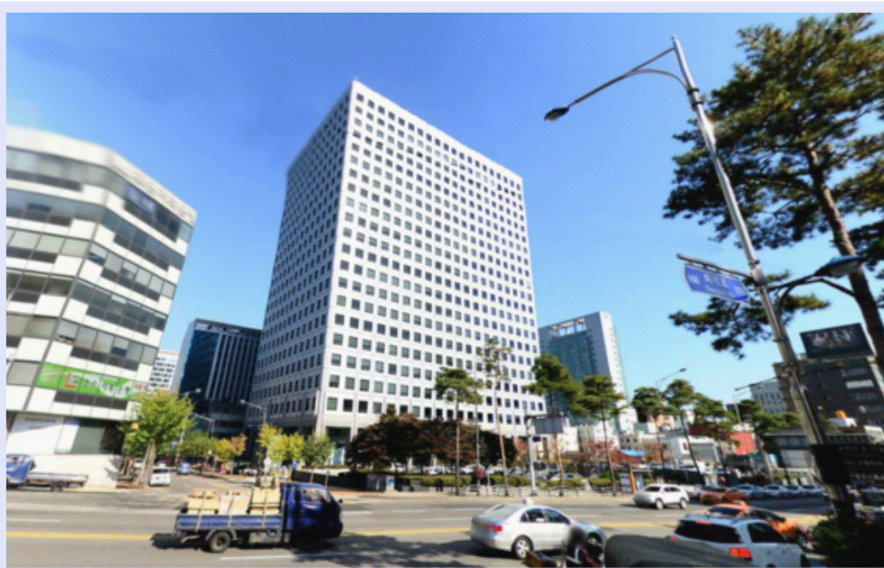
균역청 터에 자리한 남산스퀘어 빌딩(옛 극동빌딩)
