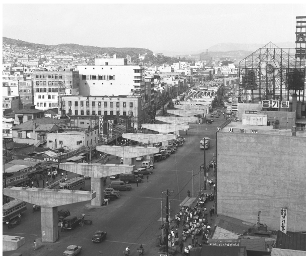
건설 중인 삼일고가도로
