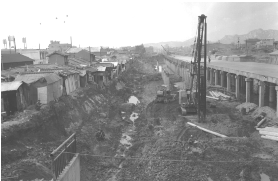
청계천 복개공사 현장(1960년대)
