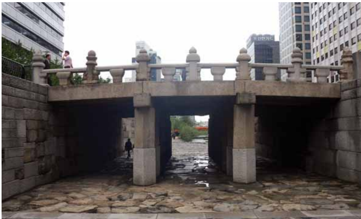
복개 공사 이전의 광통교와 청계천 복원 후 장소를 옮겨 새로 만든 광통교.
